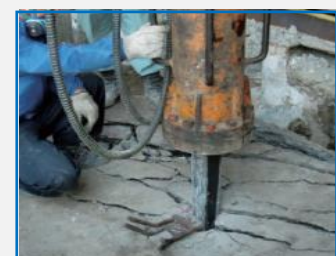
写真5 油圧割岩工法 2)
