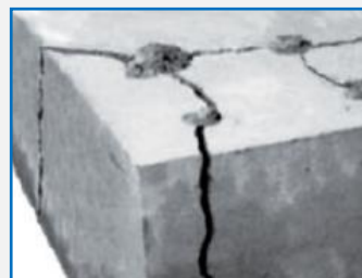
写真4 静的破碎剤工法 2)
