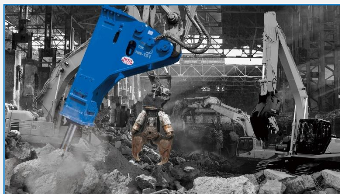
写真1 ブレーカ工法と圧砕工法 1)
